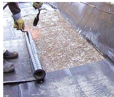
Panelový dům Ostrava, Šeříková ulice, pokládání hydroizolace na střeše ze SIOPOR-BETONu
